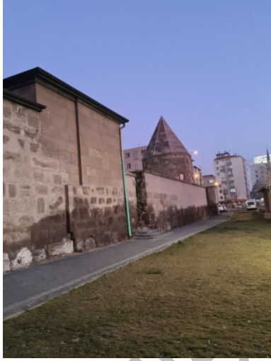
Han Camisi'nin batı duvarındaki güneye giden sur kalıntıları
