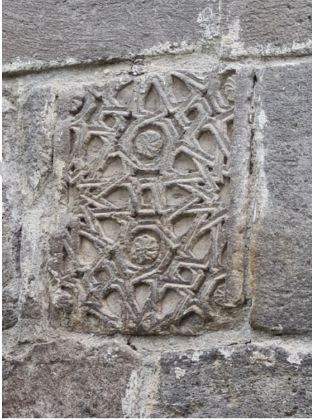
Aynı Selçuklu Yapısından Alındığı Anlaşılan Malzeme
