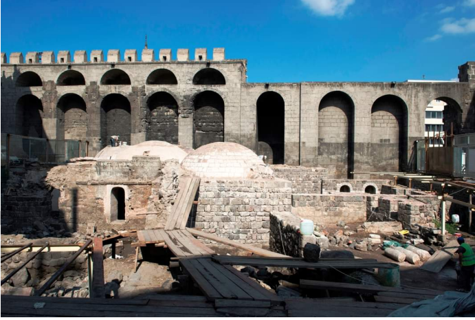
Çift katlı Justinyanus Surları ve Sultam Hamamı restorasyonu
