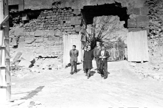
İç Kale Kuzey Kapısının İnşaat Sebebiyle Açılması. Kayseri Valisi Yüksel Çavuşoğlu ve Belediye Başkanı Hüsamettin Çetinbulut 1987-88 (Ahmet Zorlu Kol.)
