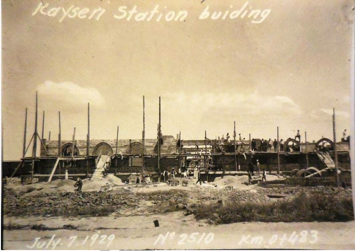
Kayseri Tren İstasyonu binasının inşaatı Temmuz 1929
