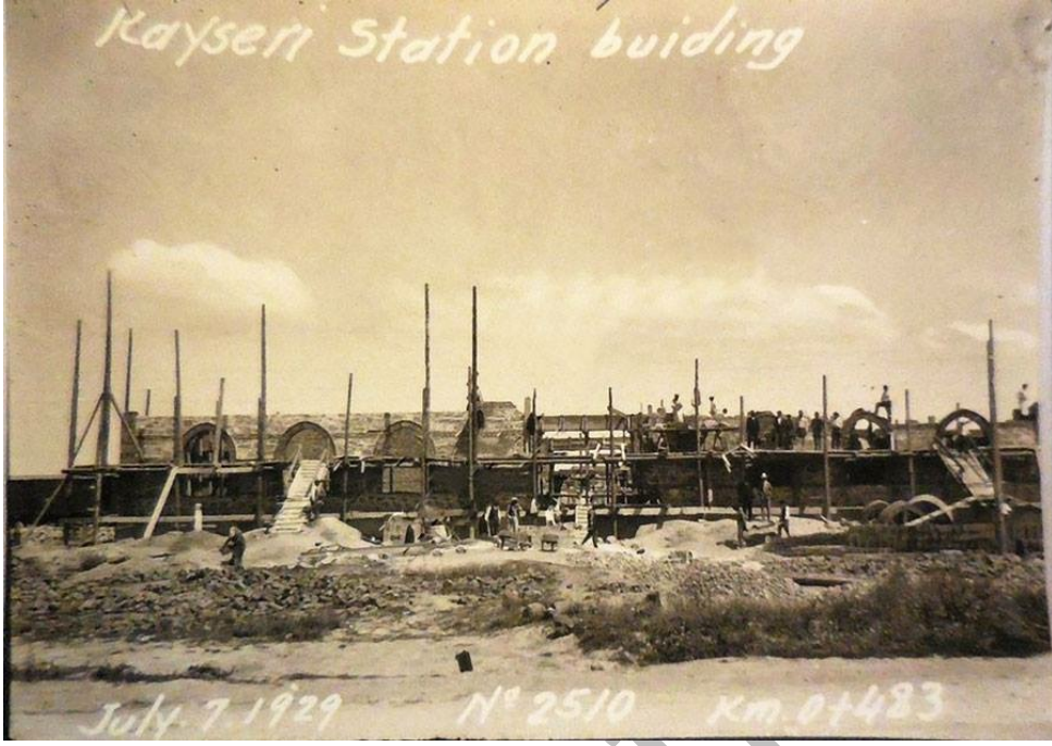
Kayseri Tren İstasyon binası inşaatı Temmuz 1929
