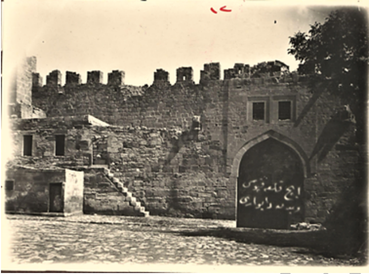
“İç Kale Kapısı ve Beden Duvarı”
