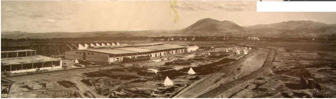
Sümer Bez Fabrikası İnşaat Hâlinde
