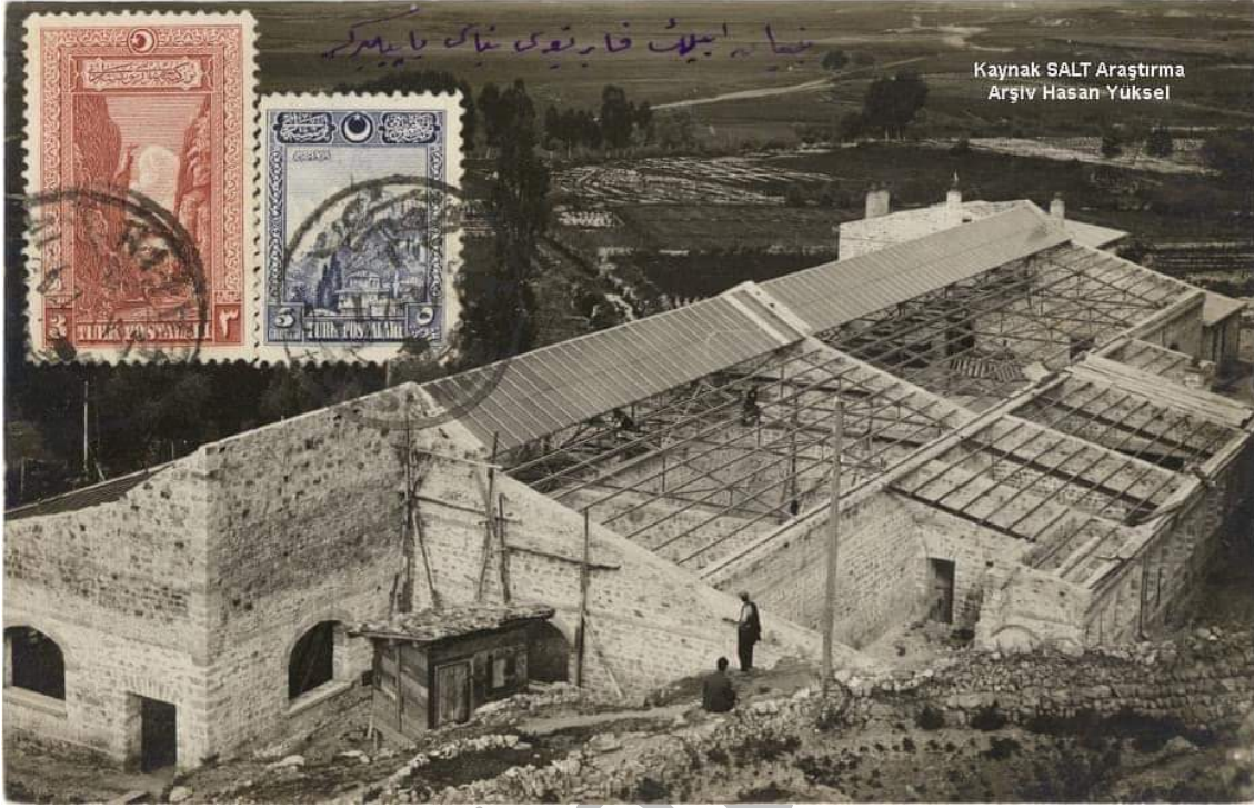
Bünyan İplik Fabrikası 1926 inşaat hâlinde (Hasan Yüksel Arşivi)
