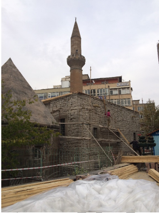
Şeyh İbrahim-i Tennûrî Câmî î ve Türbesi Mayıs 2015
